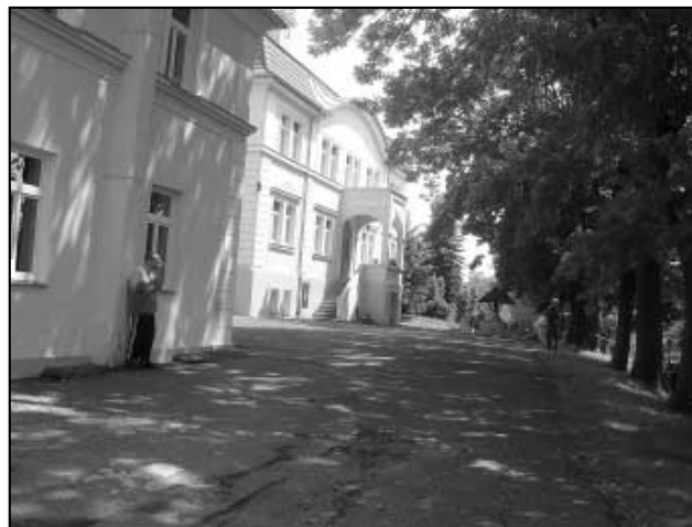
Pohled na hlavní budovu dnes.
