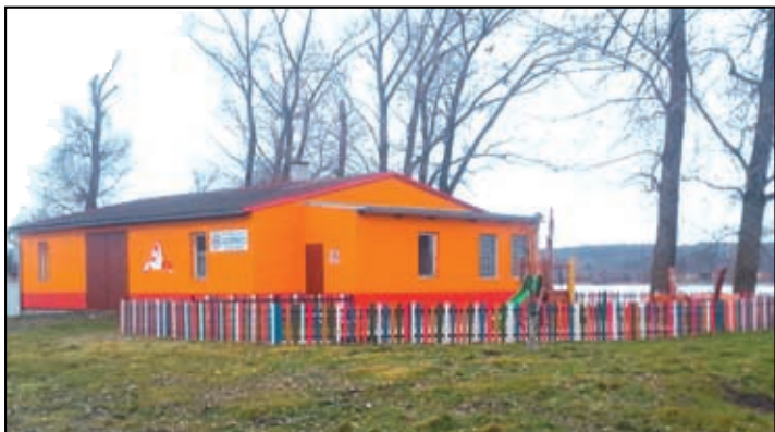
Oprava loděnice po povodni.
