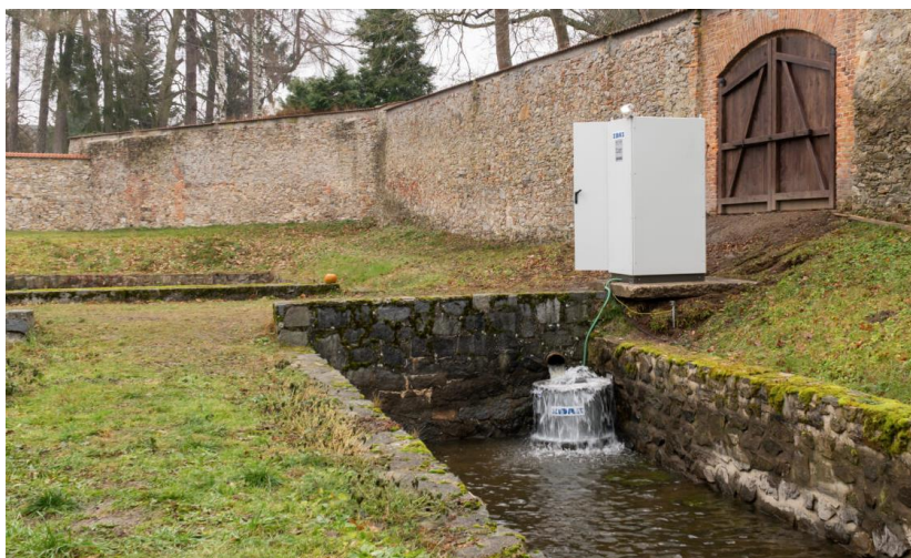
Obrázek: Příklad umístění vodní mikroturbíny na výpusti. Zdroj: ŽŽAS, a. s.
